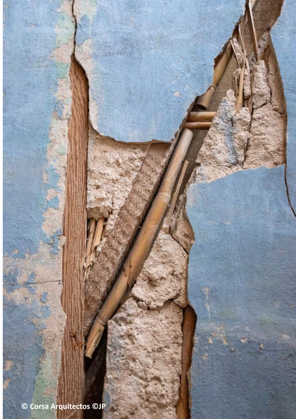
Img. n°81 Registro fotografico insitu estado de muros de anhidrita. © Corsa Arquitectos ©JP
