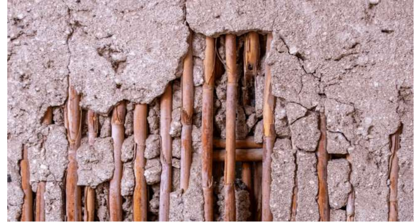
Img. n°76 Casa Morales Bermudes ejemplo de sistema constructivo. © Corsa Arquitectos ©JP
