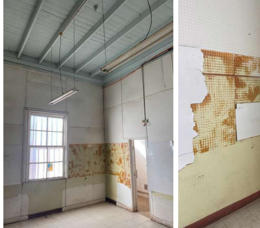
Img. n°79 Situación actual de tabiques (recinto R11). © Corsa Arquitectos.
