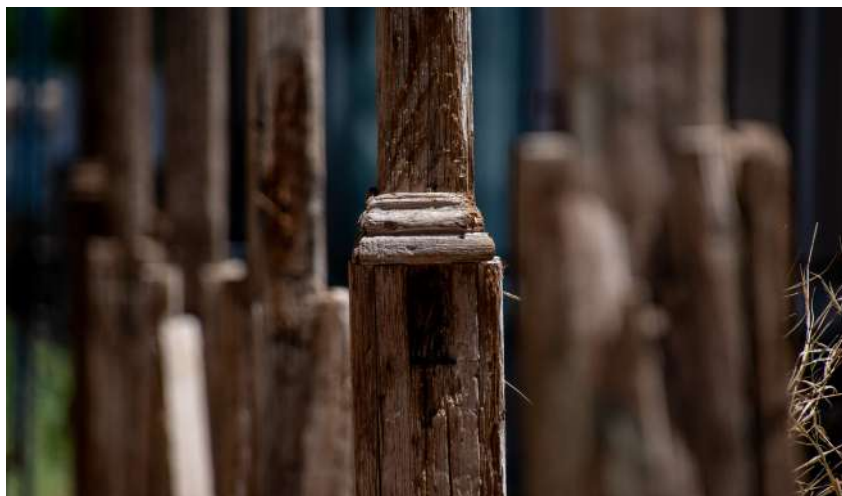
Img. n°69 Registro fotográfico de la condición actual de elementos estructurales © Corsa Arquitectos ©JP
